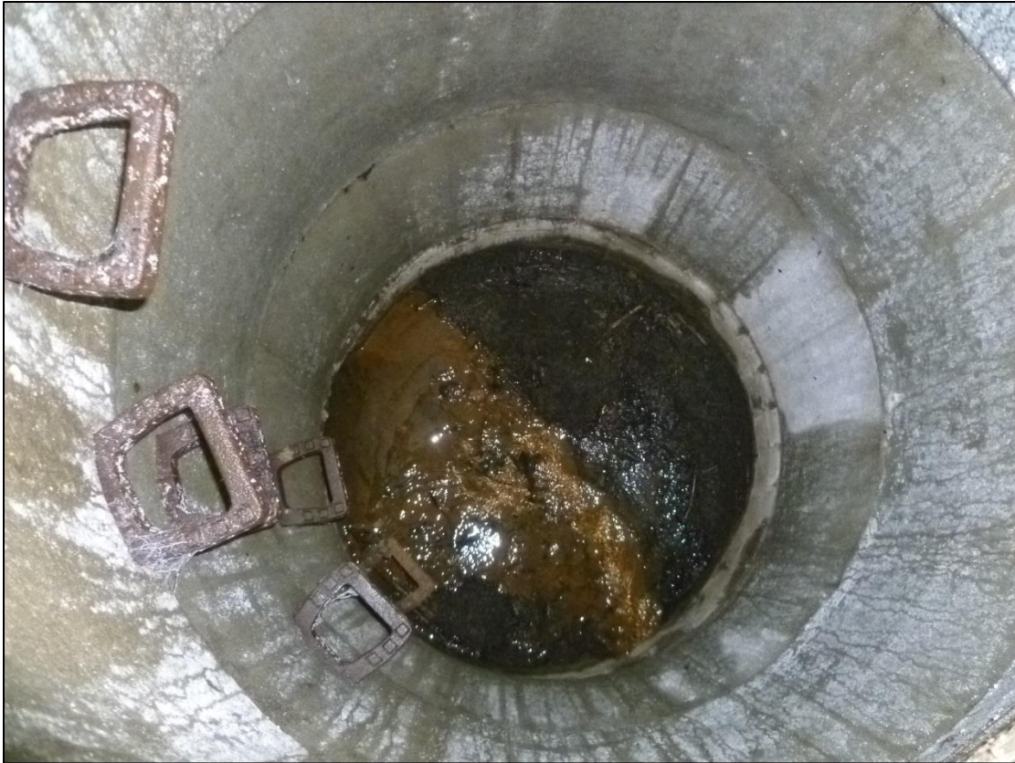
Foto 3: Betonschachtbauwerk DN1000 im nördlichen Bereich des B-Plangebiets, südlich Gleisanlage
