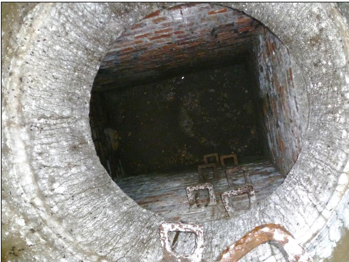
Foto 10: aus Mauerwerk bestehendes Schachtbauwerk Ende Pütterweg, vor Treppenanlage
