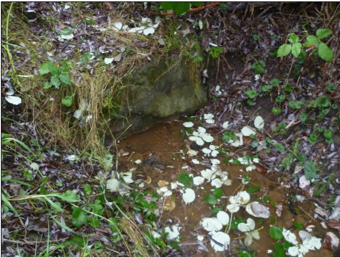
Foto 2: versandetes Auslaufbauwerk in den Entwässerungsgraben im nördlichen B-Plangebiet
